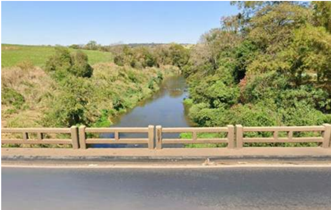
Ponte sobre o Rio Jacaré, nas proximidades do KM 30 da BR 153
