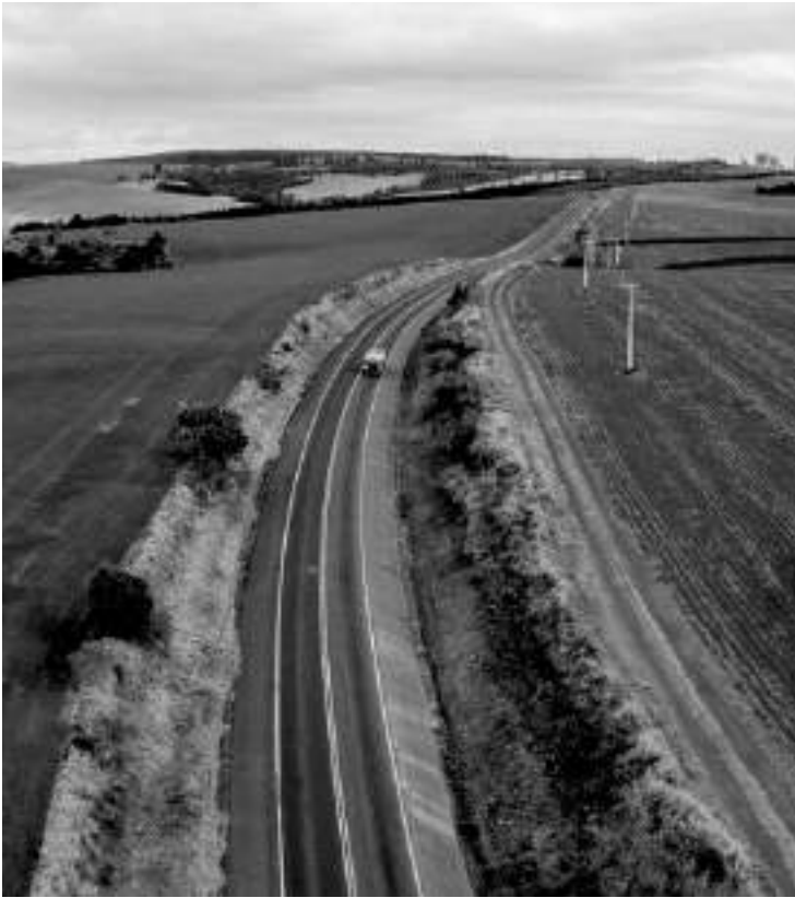
Trecho administrado pela rodovia que realiza as melhorias na região
