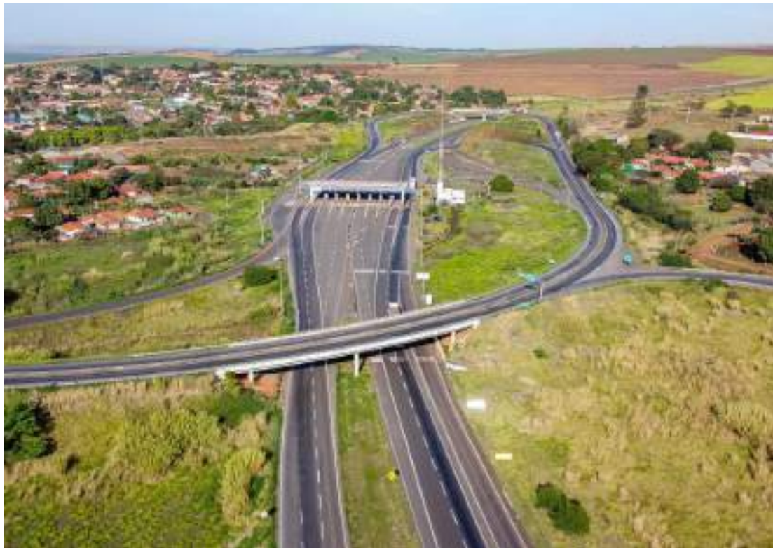
Praça de pedágio cerca moradores de Marques dos Reis
