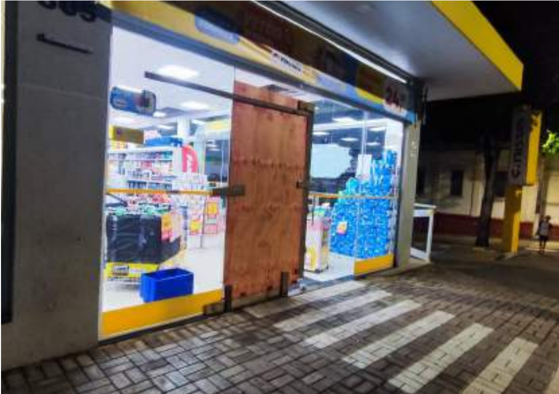
Farmácia na avenida Getúlio Vargas, esquina com a Quintino, teve vidro destruído
