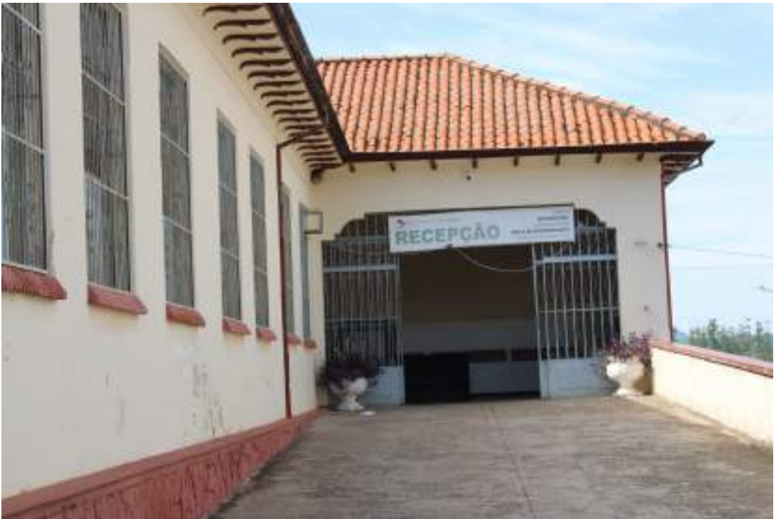
Santa Casa de Jacarezinho (Foto: Carlos Rodrigues - Minuto Notícia)
